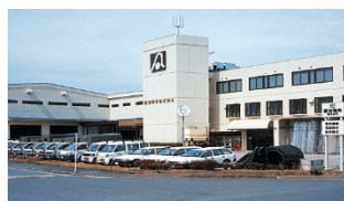
小田原本社ビル
