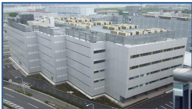
データセンター
