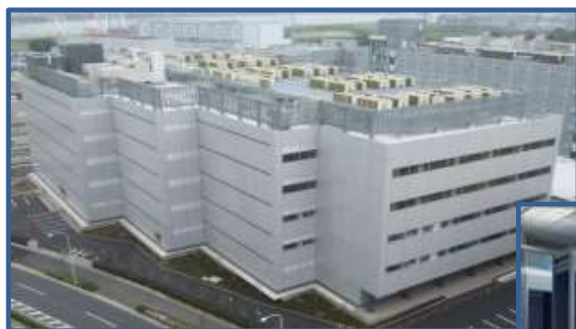
データセンター
